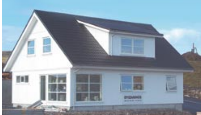
Dieses Musterhaus in Thorshavn/Färöer erstellte das Unternehmen Dy mit dem in Dänemark vorfabrizierten Holzbau-elementen im Sommer 2005. This model house in Thorshavn/Färöer was built by the Dygdarhus company in the summer of 2005, which includes the prefabricated frame panels from Denmark.
