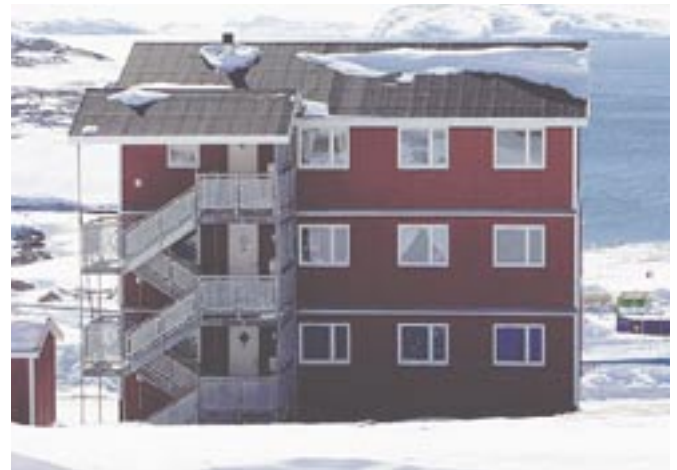
Die Wand und Dachbauteile dieses Mehrgeschossers im grönländischen Nuuk stammen aus Dänemark. Das Tragskelett besteht aus Beton. The wall and roof elements of this multiple-story house in Nuuk, Greenland are from Denmark. The main structure is concrete.
